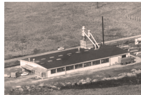
Das Produktionsgebäude nach dem Umzug 1968.
